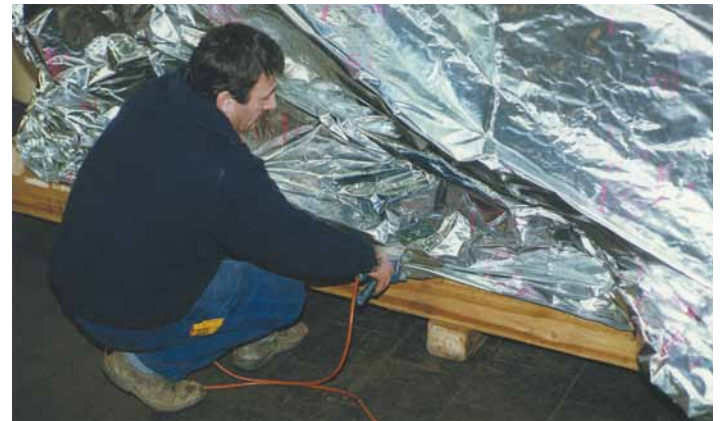
3. Haube und Boden werden zusammenschweißst.
