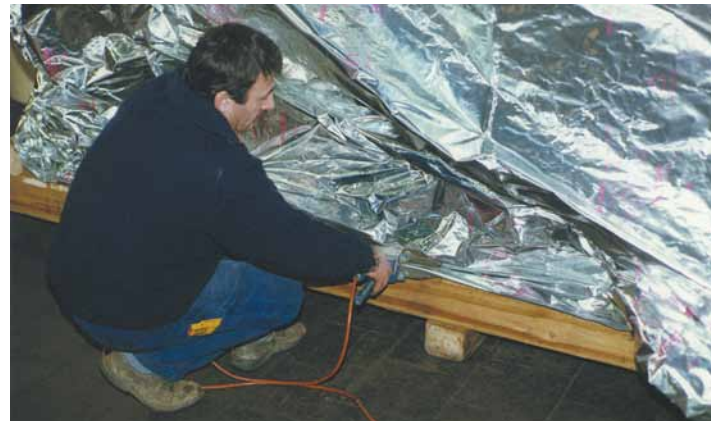
3. Haube und Boden werden zusammenschweiß.
