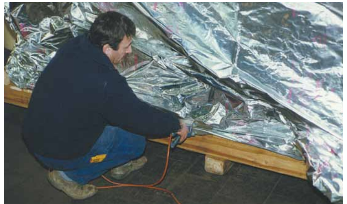
3. Haube und Boden werden zusammenschweißst.
